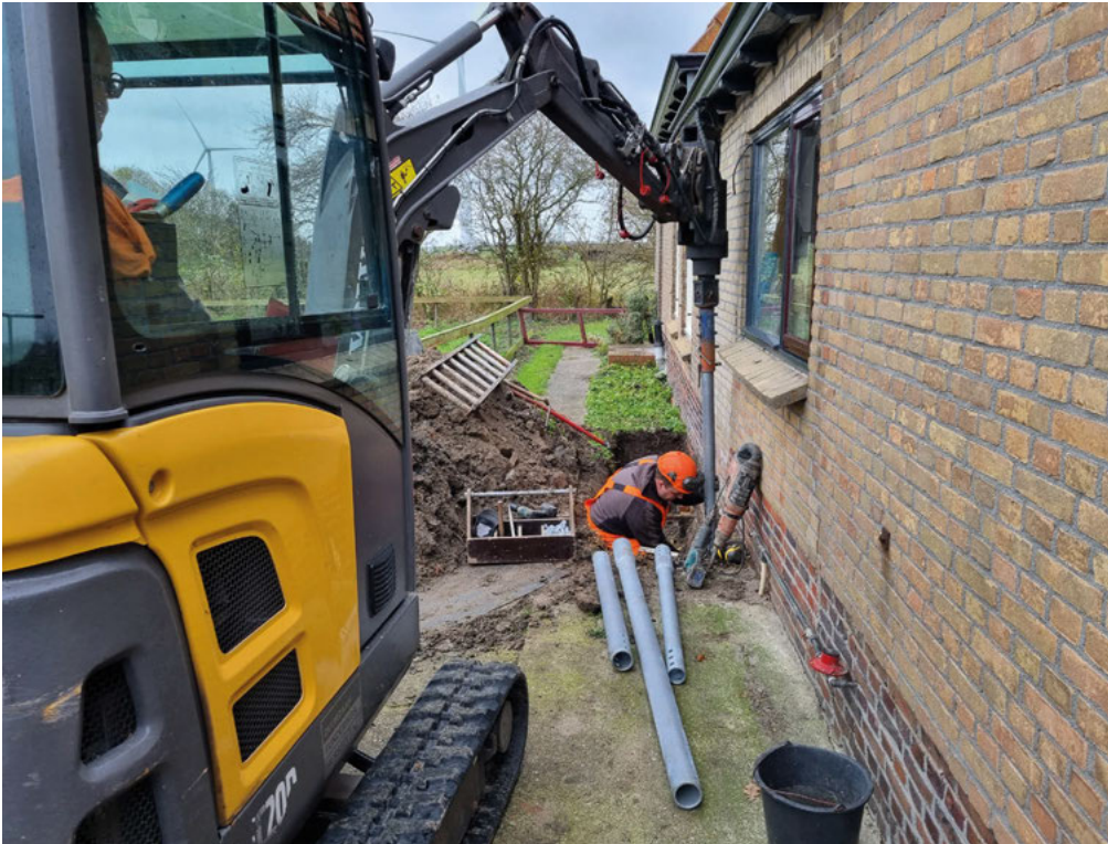
De speciale DFH-palen worden met behulp van een minikraan in de grond gedraaid. Dankzij deze techniek blijft de overlast voor bewoners en omgeving tot een minimum beperkt. (foto Duurzaam Funderingsherstel)
