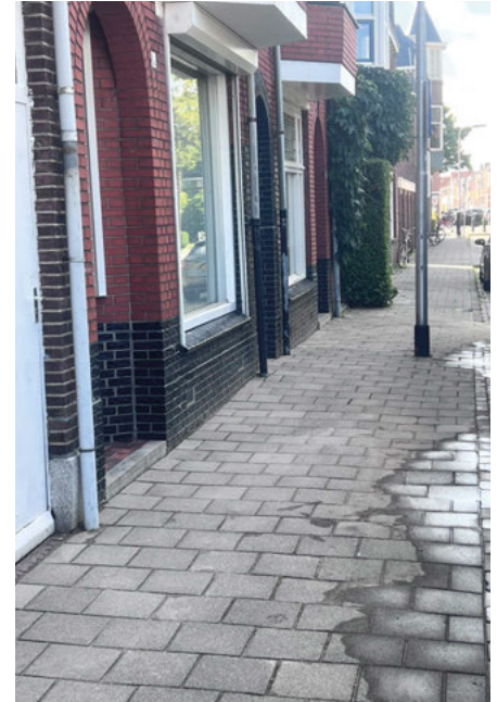
Na afloop van de werkzaamheden wordt de straat, tuin of binnenruimte waar gewerkt is, weer teruggebracht in staat van voor aanvang van de werkzaamheden. (foto Duurzaam Funderingsherstel)
