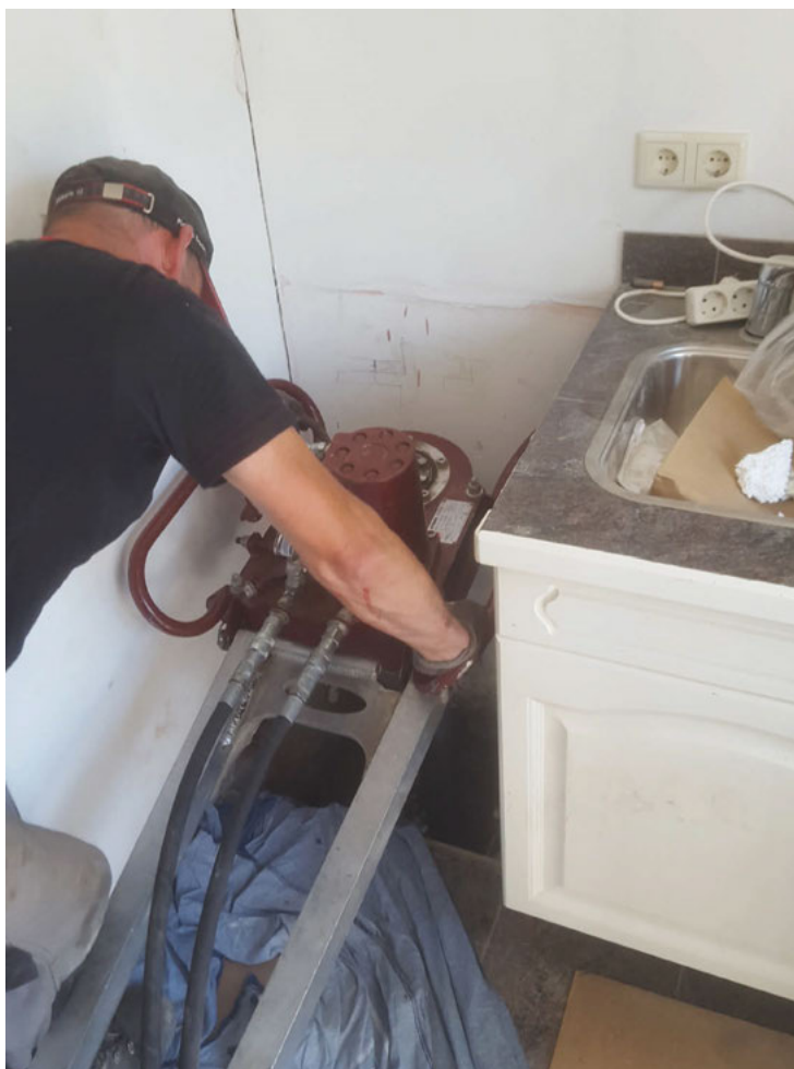
Ook voor werkzaamheden in een woonhuis of gebouw wordt gebruikgemaakt van een speciale boor die de palen tot op de draagkrachtige laag in de grond draait. (foto Duurzaam Funderingsherstel)
